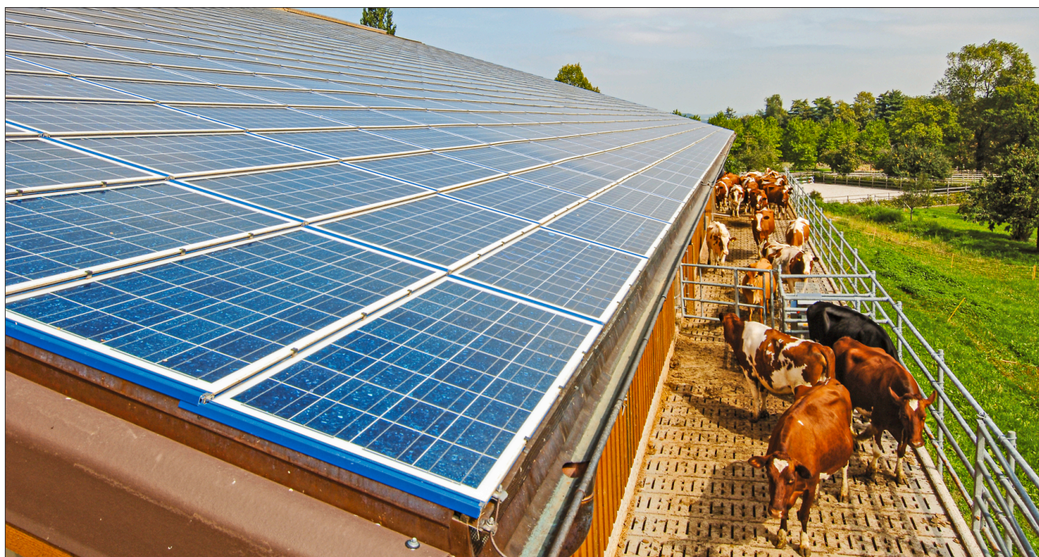
Diese Anlage in Barberêche FR mit 110-kWp-PV-Anlage produzierte von 2005 bis 2016 durchschnittlich 125 000 kWh/a. Das übertrifft die Erwartungen, man hat damals mit 105 000 kWh/a gerechnet. (Bild: Solar Agentur Schweiz/Schweizer Solarpreis 2006)
